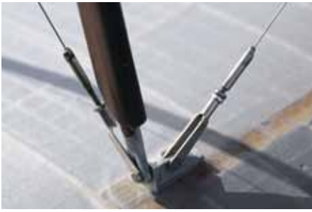
Um die nicht lötfähigen Diamantlitze als Spannseile nutzen zu können, geben Quetschverbindungen den nötigen Halt bei der Schraubmontage
